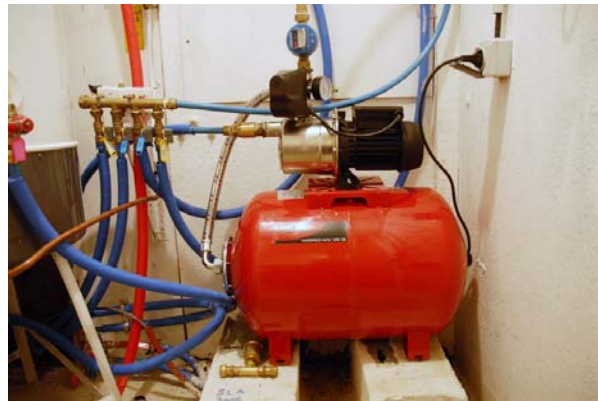
Remplacement du surpresseur éclaté par le gel l'hiver dernier
