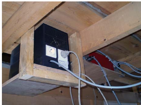
Installation du transfo de protection sous le ring du T62
